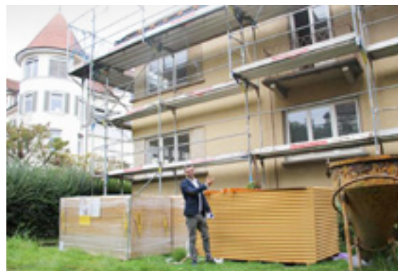
Zustiftung und Renovation der Villa Oppold
