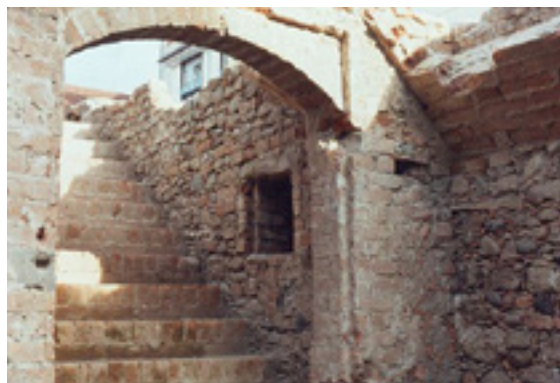
Fundamente des ursprünglichen Bruderhauses
